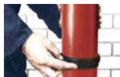
Monter det andre røret og bøy gummipakningen tilbake over det øvre røret
