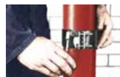
For PAM CV-CE koblinger: Fest de to strammeskrueene og skru til for iht angitt moment. De gjengede platene må ligge parallelt for å unngå å bli deformert.
