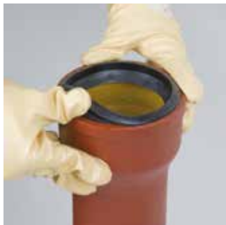
Sett gummipakningen inn i muffen
