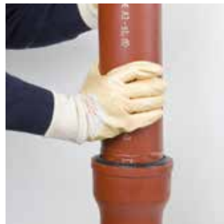
Skyv rørdelen inn på spissenden og påse at pakningen sitter i rett posisjon og at røret skyves helt inn til pakningens senterring.
