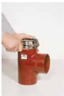
Skyv koblingen på spissenden inn til røret treffer gummipakningens senterring
