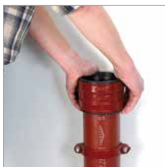
Trykk koblingen over spissenden på røret og påse at røret går helt inn til pakningens senterring.
