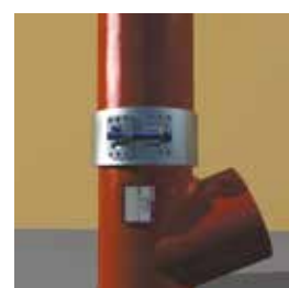
Sammenkoplingen gjøres enkelt ved bruk av rørkoblinger og gir en kompakt og tett løsning.
