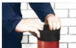
Skyv gummipakningen på spissenden inn til senterringen
