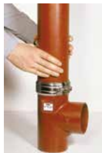
Stram skruen til det ikke er synlig spalte i metallhylsen. Bruk skralle eller batteridrill.
