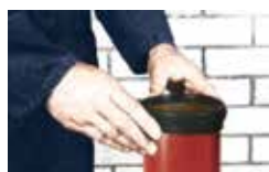
Rull den øvre halve delen av gummipakningen tilbake over den nedre
