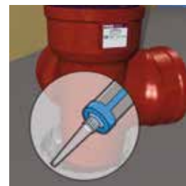
Forsegl åpningen med sement eller annet egnet tettemiddel
